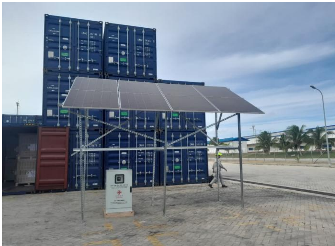
Spende von 5 000 Photovoltaikanlagen für abgelegene Gemeinden Foto: Wennys Díaz Ballaga Photo: Granma
